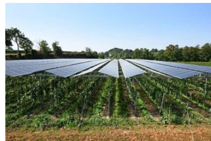
Abbildung 11: Viti-PV Fixinstallation – Reihenüberspannt
