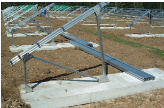
Abbildung 23: Streifenfundamente
