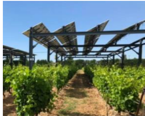
Abbildung 14: Viti-PV mit nachgeführten Solarmodulen auf einer reihenüberspannenden Tragwerksunterkonstruktion [Quelle: Tiffon Terrade et.al. 2021]
