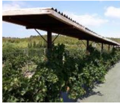
Abbildung 10: Viti-PV Fixinstallation – Einzelausführung
