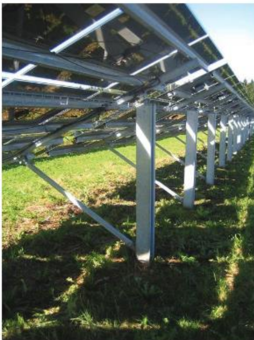
Abbildung 25: Stahlrammprofile und eingerüttelte Stahlrohre
