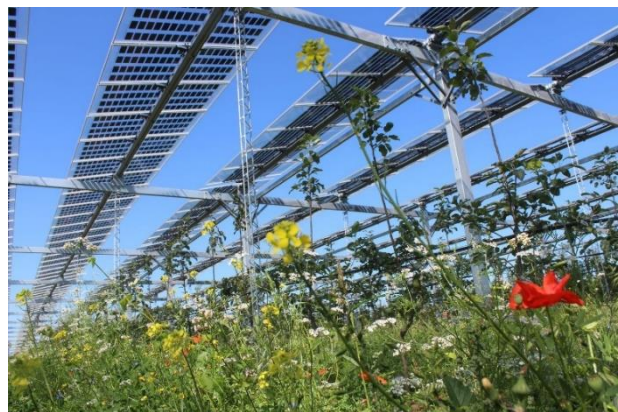
Abbildung 34: Partial transparente Module der Agri-PV-Anlage im Obstbau des Fraunhofer ISE [Quelle: Fraunhofer ISE 2020b]
