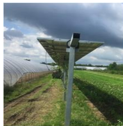
Abbildung 12: Viti-PV Fixinstallation mit Tracking System
