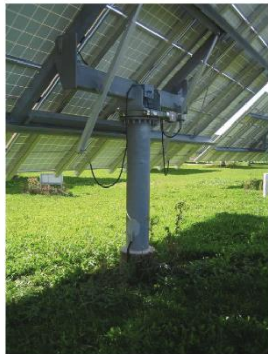
Abbildung 25: Stahlrammprofile und eingerüttelte Stahlrohre
