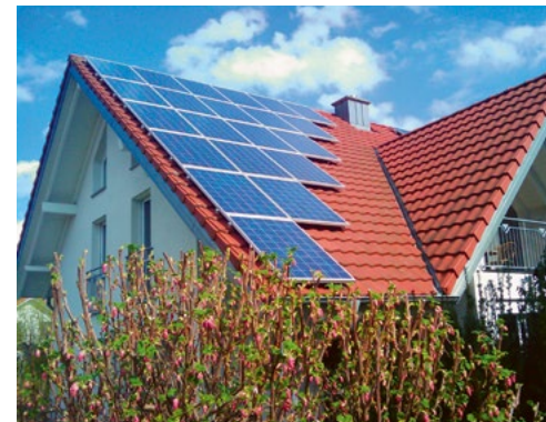
Mit Photovoltaik sauberen Strom aus Sonnenschein gewinnen
