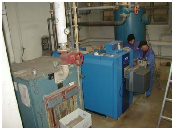
Neuer Gas-Brennwertkessel
