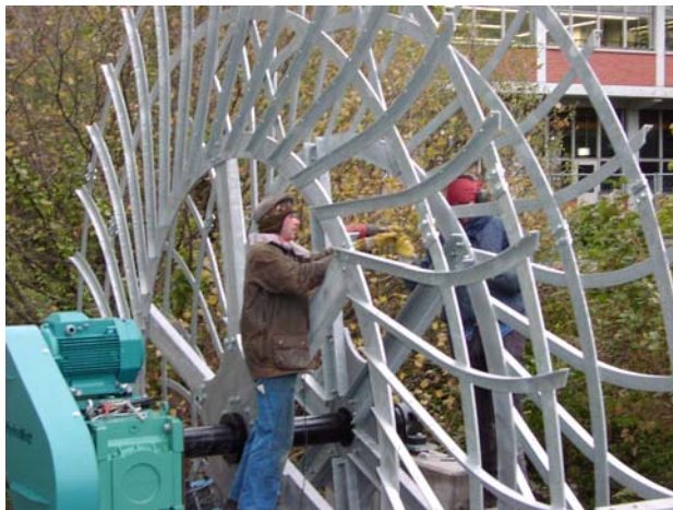
Bild 6 : Montage des Wasserrades
