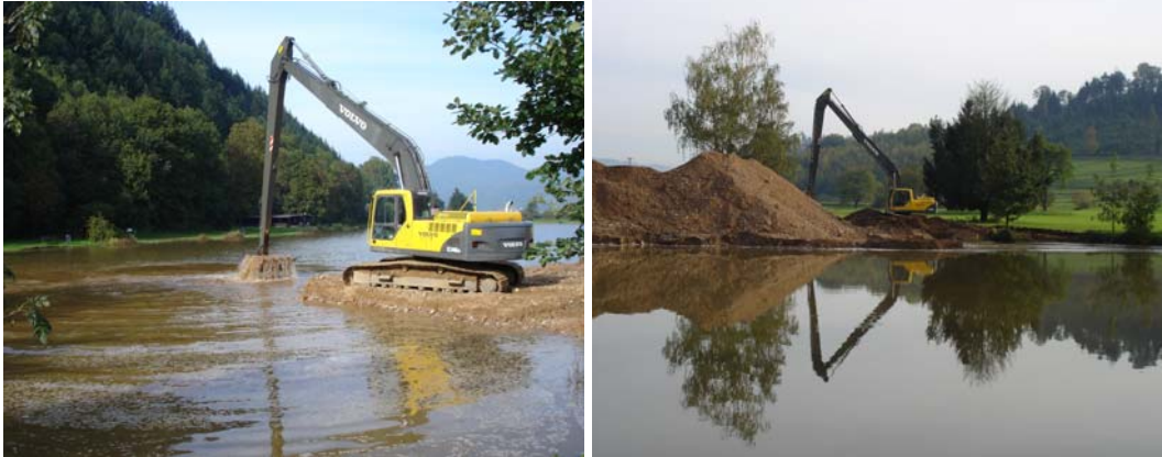
Abbildung 2-4. Schlamm- und Kiesentnahme mittels Bagger vom Ufer aus.
