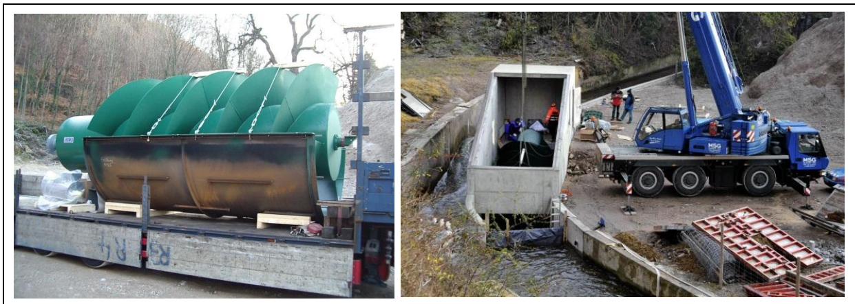
Abbildung 18: Anlieferung und Einbau der Wasserkraftschnecke
