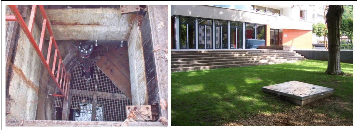
Abbildung 16: Bestehender Grundwasserbrunnen „Coats“ mit neuer Grundwasserpumpe und fertiggestellter Brunnen.
