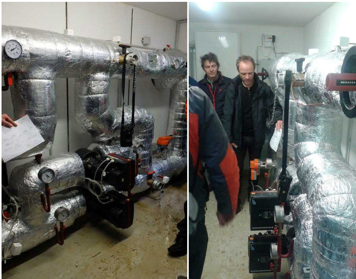
Abbildung 6: Fernwärme-Regelstation
