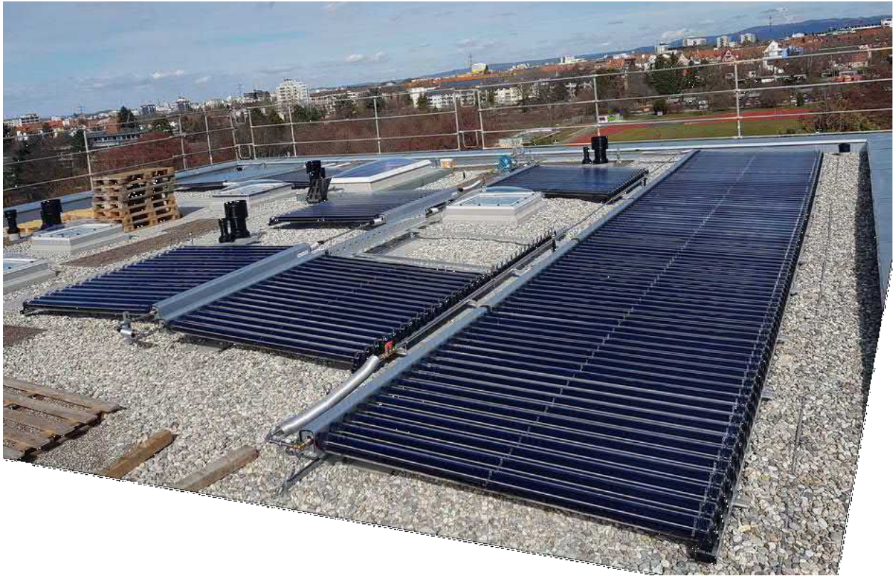
Abbildung 22: Vakuump-Röhrenkollektor-Anlage „Solaris“: Gesamtansicht während der Montage
