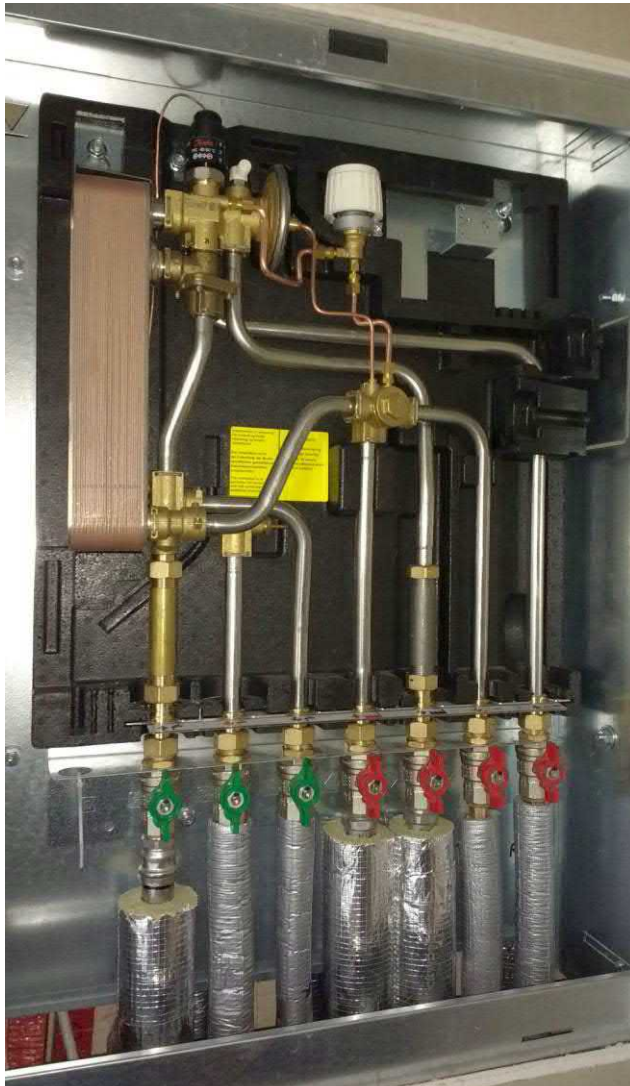
Abbildung 11: Wohnungsstation YADOS HOME 0D-xH-1DD (55kW)
