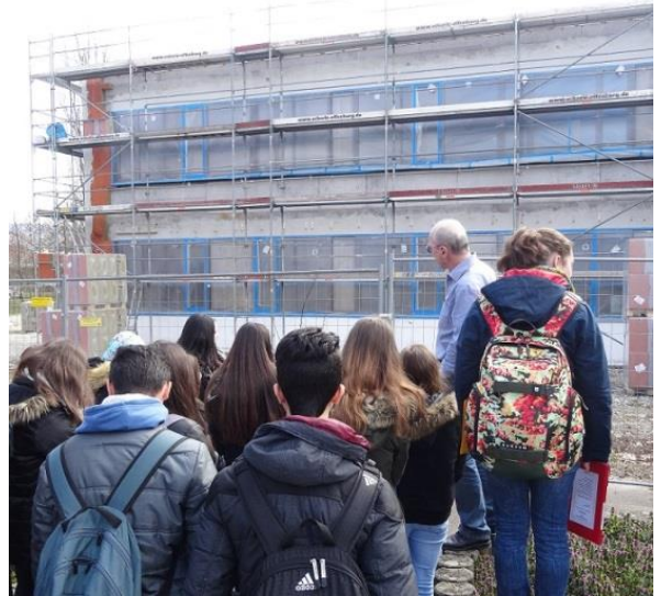
Abbildung 2: Exkursion zu einer Sanierungsbaustelle (Foto: Stefanie Witt, fesa e.V.)
