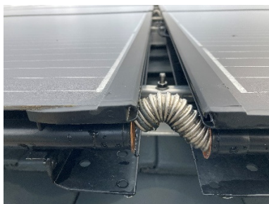
rausgedrückter Kollektorverbinder
