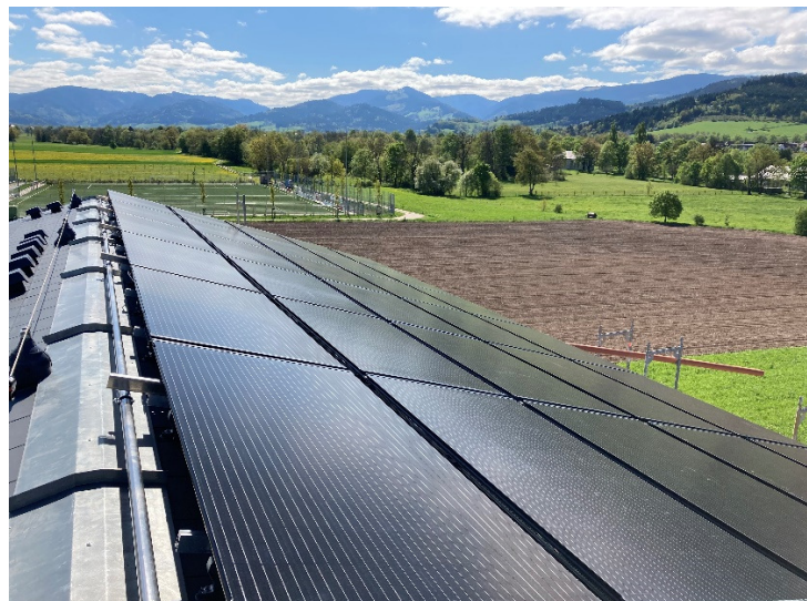
fertiggestellte PVT-Anlage
