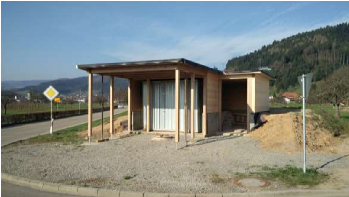
Abbildung 1: Technikgebäude integriert in Bushaltestelle
