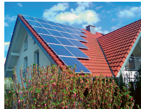
Mit Photovoltaik sauberen Strom aus Sonnenschein gewinnen und speichern
